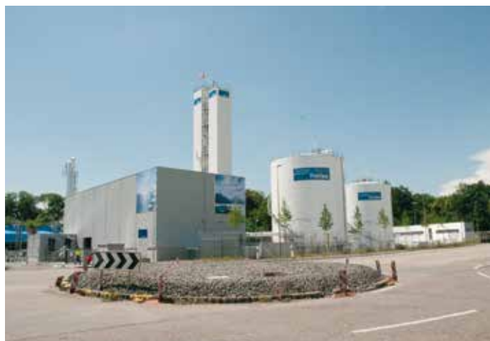
Unité de séparation des gaz de l'air de Muttenz.
