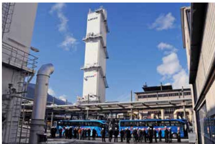
Die seit Mitte 2009 bei der Lonza AG in Visp im Wallis in Betrieb stehende Luftzerlegungsanlage der Messer Schweiz AG.
