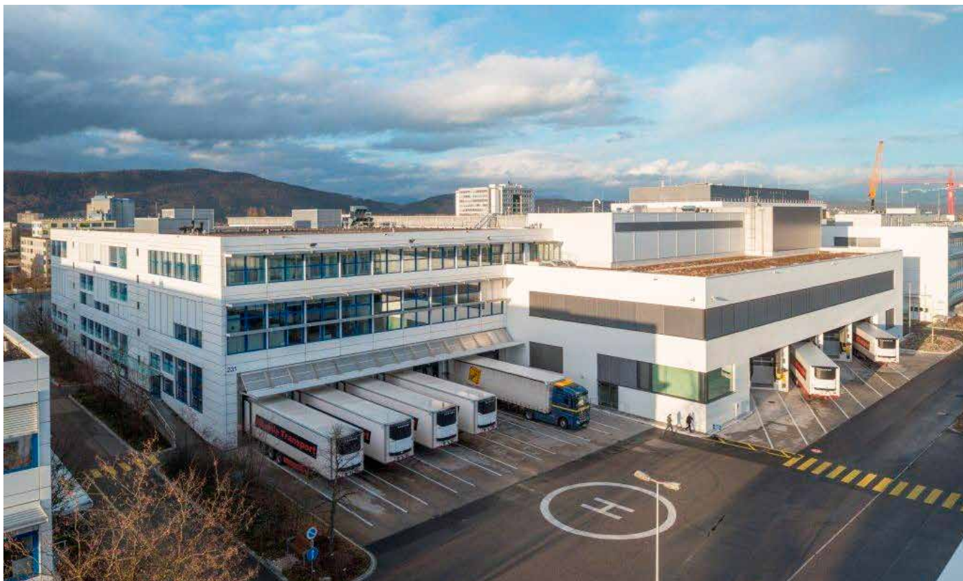
Aussenaufnahme des Lager- und Logistikzentrum der F. Hoffmann-La Roche AG in Kaiseraugst. Linksseitig sieht man die sieben LKW-Rampen für den Warenumschlag der Normaltemperatur-Materialien und auf der rechten Seite die vier LKW-Rampen für die Kühl-Materialien.
