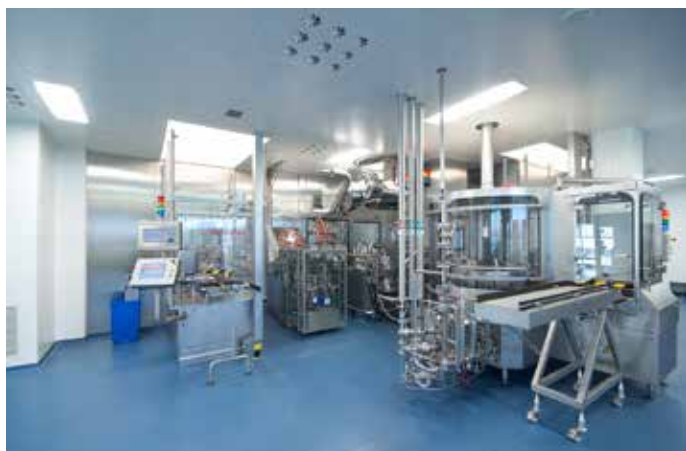
Blick auf die Abfülllinie des Gefrier-trocknungsmoduls. Abfüllmaschine in RAPS (Restricted Access Barrier System)-Ausführung.
