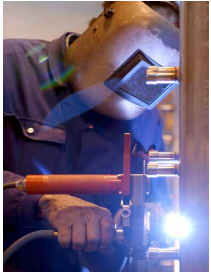
Abb. 7: Orbital Schweissverfahren mit offener Zange. Schweissautomat speziell für das hochpräzise Einschweissen von Kühlanschlüssen in Kühlringe zur Generatoren-Kühlung von Apaco entwickelt. Es wird auf kleinstem Raum 3-lagig geschweisst. Die Schweissnähte werden PT geprüft, endoskopiert und danach ein Helium-Leckagetest ausgeführt.
