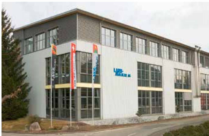
Firmengebäude mit neuem Obergeschoss (nach Minergiestandard).
